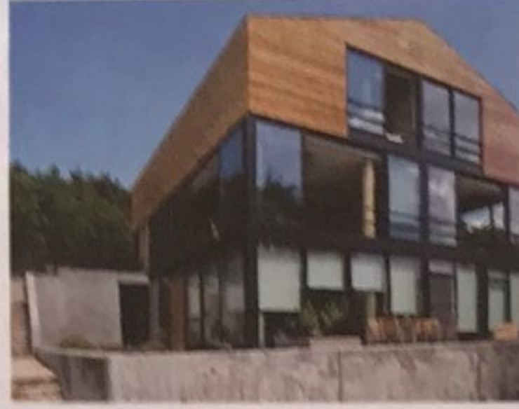
Büyükada'da Konut, İstanbul Suyabatmaz Demirel Mimarlık 61.
