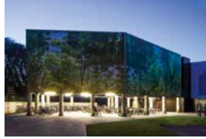
Carlos Arroyo Arquitectos 114.
